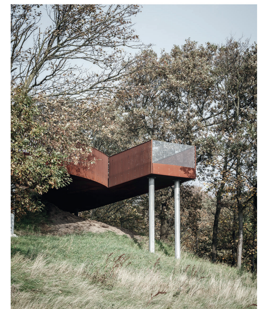
Eksempel på ny stibro ved stationen, Landgangen i Esbjerg. Bro og udsigtspunkt
